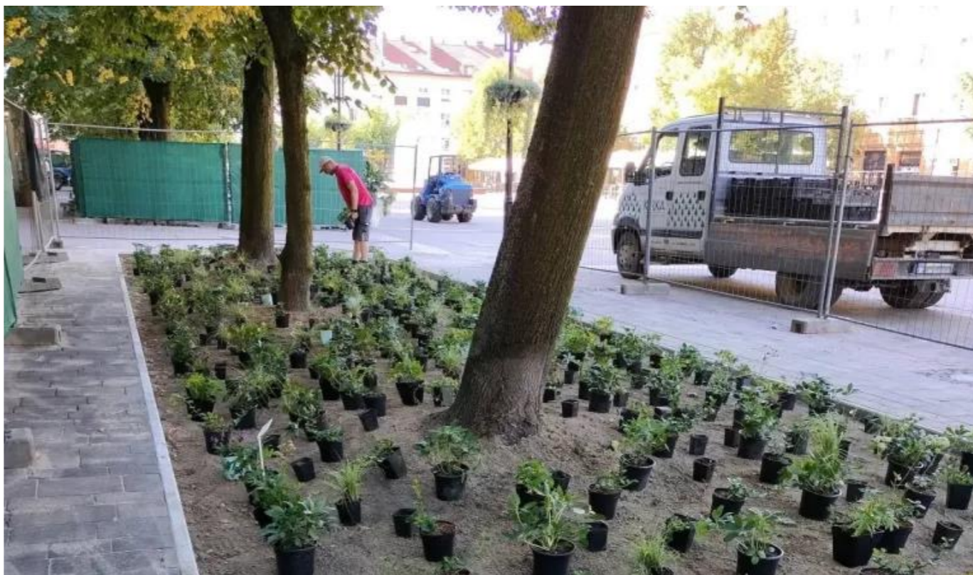
Rozszczelnienie nawierzchni Placu Baczyńskiego na ukończeniu · fot. UM Tychy Źródło: https://www.tychy.info .
