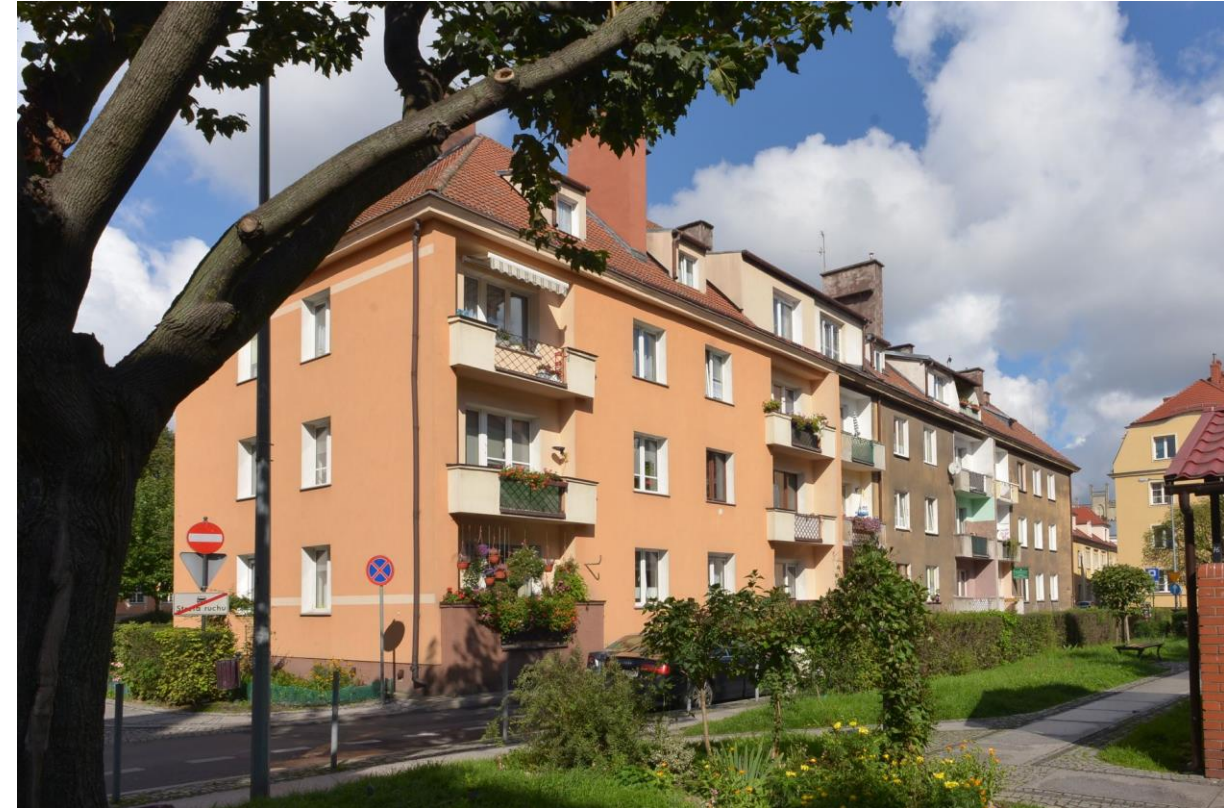
Ul. Braci Śniadeckich 1-6, 1959 r., autor projektu: inż. Helena Firych, fot. K. Czartoryski, 2022
