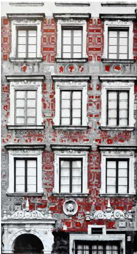
16. Kamienica Pod Murzynkiem przy Rynku Starego Miasta 36, mapa zachowanych partii sgraffito z 1953 r., stan w 2015 r.
