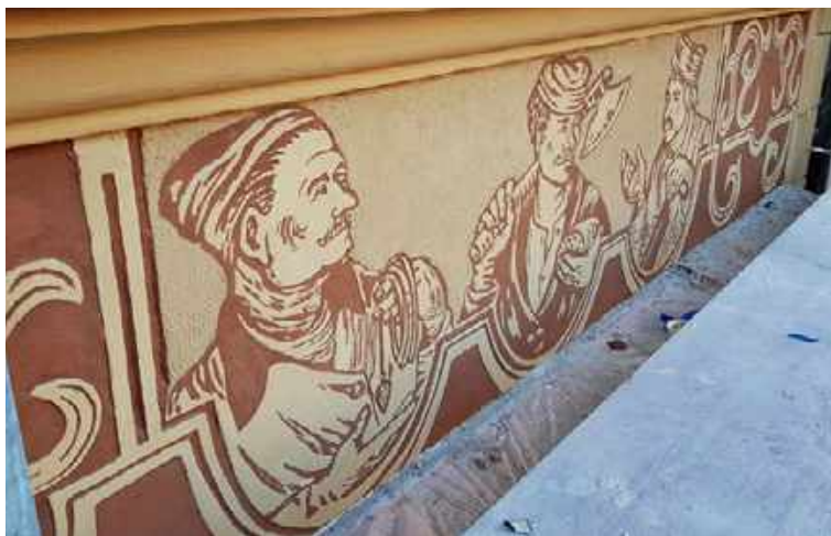
23. Ul. Szeroki Dunaj 9, detale dekoracji sgraffitowej, po zakończonych pracach
