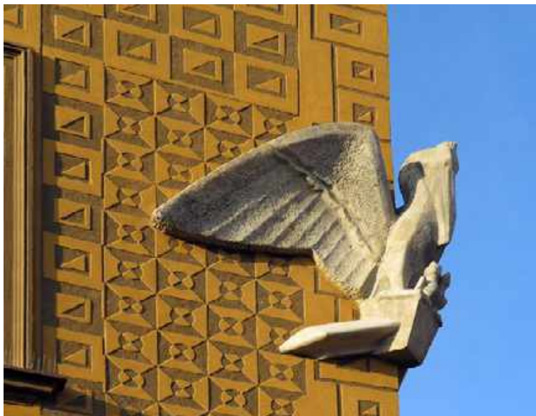
16. Pl. Zamkowy 1/13, detal dekoracji sgraffitowej i rzeźby pelikana po zakończeniu prac
