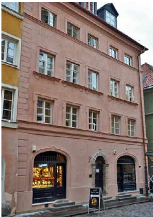
17-18. Elewacja kamienicy przy ul. Piwnej 12 przed i po zakończeniu prac konserwatorskich
