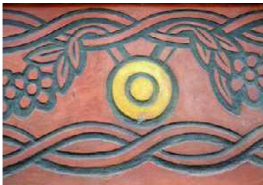
3-4. Dekoracja sgraffito przed i po wykonaniu prac konserwatorskich
