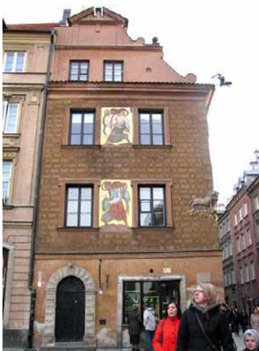
17-18. Rynek Starego Miasta 13, elewacja od strony rynku, widok przed rozpoczęciem prac; widok po zakończeniu prac konserwatorskich i budowlanych
