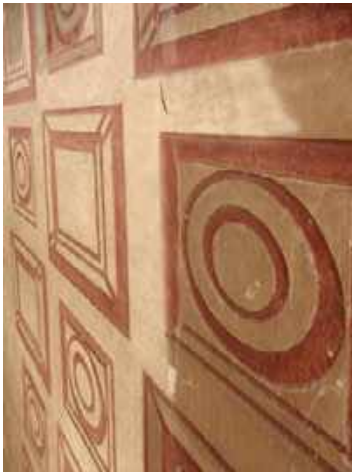
14. Dekoracja sgraffito podczas czyszczenia metodą strumieniowo-ścierną
