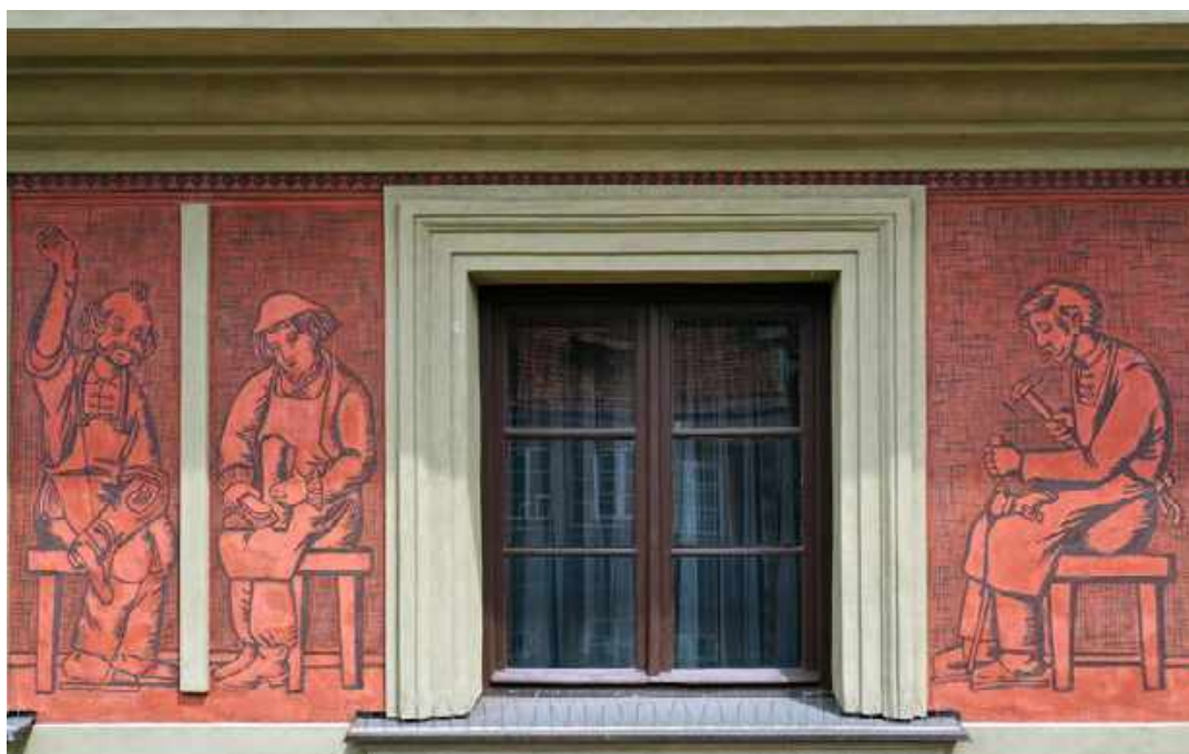
Ul. Wąski Dunaj 10, elewacja od strony ul. Szeroki Dunaj pokryta geometrycznym i figuralnym sgraffitem, wykonanym przez Jana Zamoyskiego
