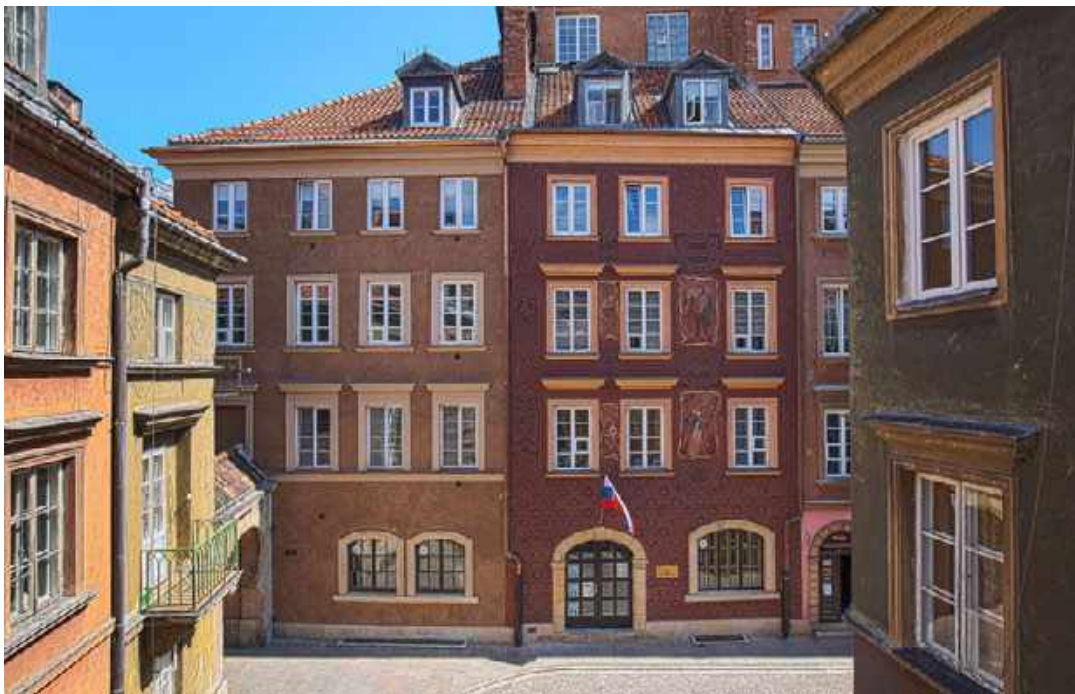
19-20. Elewacje kamienic przy ul. Krzywe Koło 12/14a, elewacja z dekoracją malarską i sgraffito oraz Krzywe Koło 6/6a z dekoracją sgraffito
