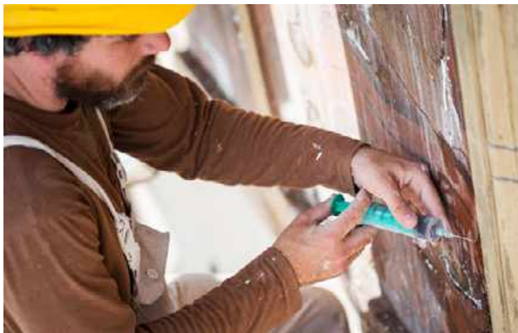
11. Podklejanie odspojonych warstw tynków barwionych w masie od tynków podkładowych
