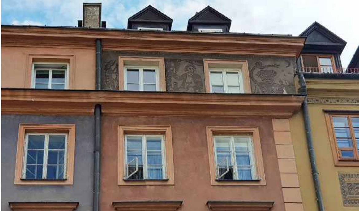
1. Rynek Starego Miasta 4, przed pracami konserwatorskimi w 2018 r., widoczny wtórny kolor i uszkodzenia dekoracji
