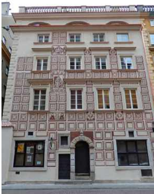
12-13. Elewacja kamienicy przy ul. Świętojańskiej 15, widok przed i po wykonaniu prac konserwatorskich
