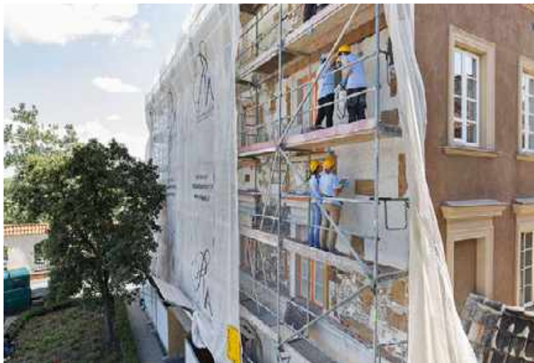
22. Kontynuacja prac przy rekonstrukcji dekoracji sgraffitowej na elewacji kamienicy Krzywe Koło 12/14a
