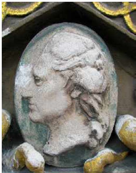
6-7. Rynek Starego Miasta 5, kamienica Pod Bazyliuszkiem, medalion z naczółka okna drugiej kondygnacji; detal sztukatorski pierwotnie polichromowany, z czasem warstwy malarskie uległy wymyciu, stan w 2016 r.; stan po zakończeniu prac, 2017 r.
