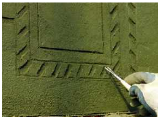
8-10. Zielona Kamienica, rekonstrukcja sgraffita
