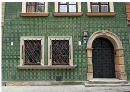
11. Zielona Kamienica, portal przed konserwacją
