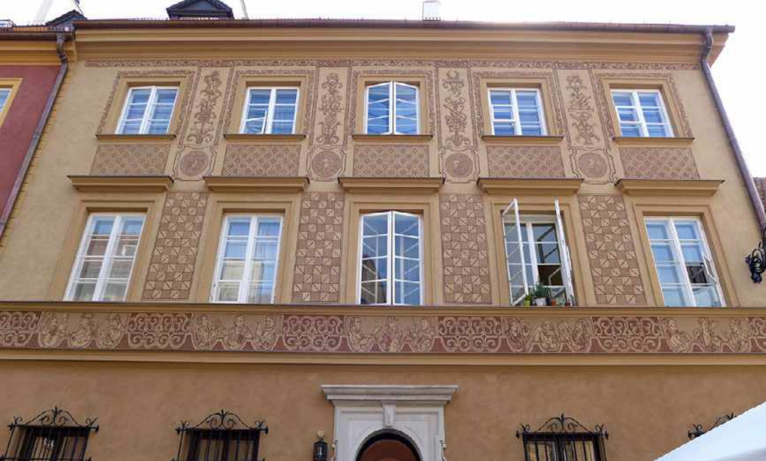
24. Ul. Szeroki Dunaj 9, detal i całość dekoracji sgraffitowej, po zakończonych pracach – efekt został uznany za niezgodny z umową dotacyjną
