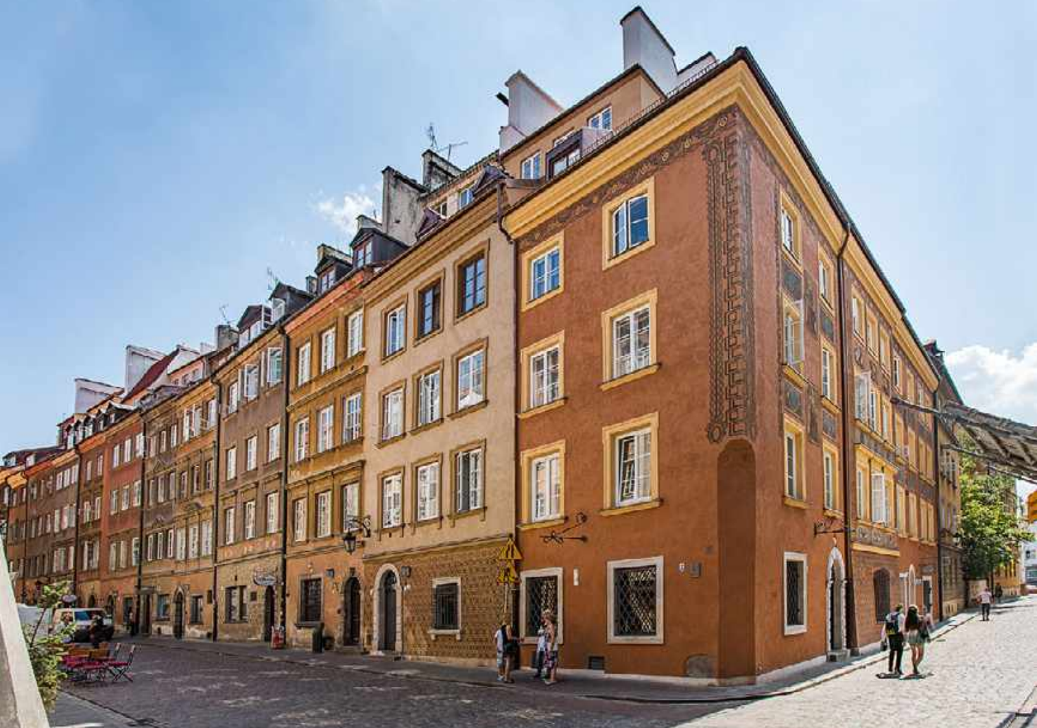
5. Elewacja kamienicy przy ul. Wąski Dunaj 3, Piwna 51/53, po przeprowadzeniu prac konserwatorskich, 2016
