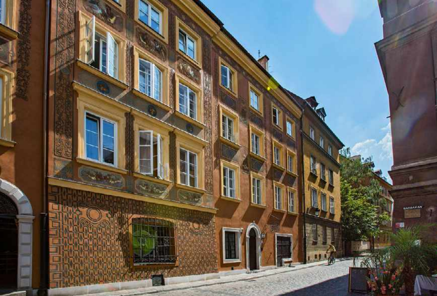
2. Elewacja kamienicy przy ul. Wąski Dunaj 3, widok po konserwacji, 2016
