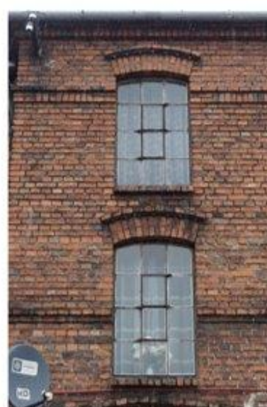
Fot. 3: Stolarka okienna, typ O-01. Fragment elewacji.
