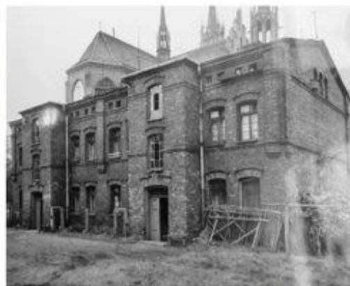
Fot. 6: Dom, ul. Wyszyńskiego 5. Widok elewacji od strony podwórza.
