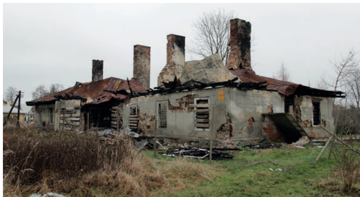
Ilustracja 14. Drewniany dwór zniszczony w wyniku pożaru, fot. B. Podubny, archiwum NID OT w Rzeszowie
