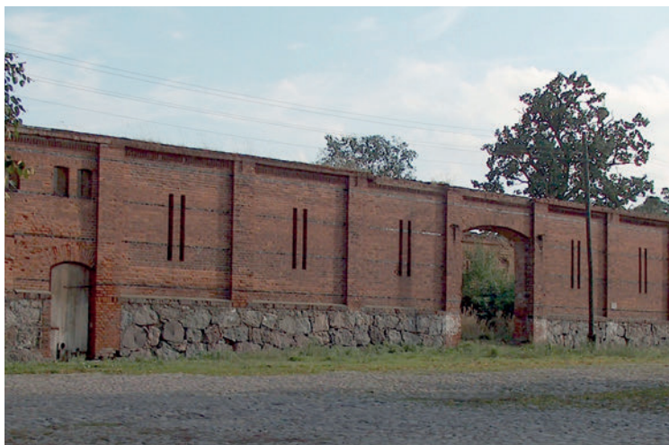
Ilustracja 24. Przelewice, dawna stodoła w założeniu pałacowo-folwarcznym, opuszczona po pożarze dachu, fot. T. Prajzendanc, Archiwum NID OT w Szczecinie
