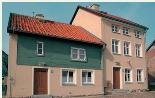
Ilustracja 16. Dobre Miasto, domy przy ul. Sowińskiego, widok od północnego wschodu, stan po remoncie, fot. I. Liżewska, archiwum NID
