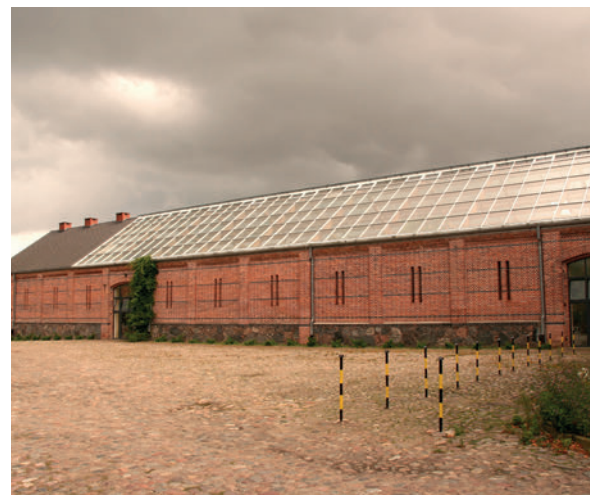
Ilustracja 25. Ten sam obiekt zaadaptowany na oranżerię roślin śródziemnomorskich Botanicznego Ośrodka Badawczo-Wdrożeniowego. Nowa funkcja zachowuje przeznaczenie gospodarcze, bryłę budynku, sylwetę dachu, kompozycję elewacji, oryginalny materiał ścian i fundamentów. Nie generuje niekorzystnych zmian i ingerencji w oryginalną strukturę i materiał, fot. I. Liżewska, archiwum prywatne
